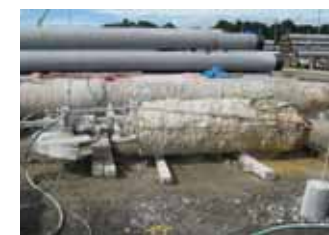
写真4 切断状況 02 (No.2 杭)
