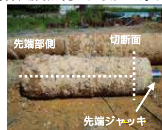
写真2 No.2 杭の切断位置
