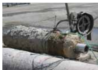
写真3 切断状況 01 (No.2 杭)
