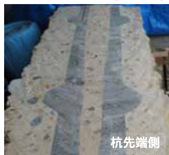
写真6 杭軸方向切断面
