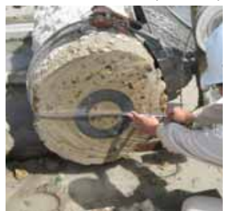
写真5 杭軸直角方向切断面
