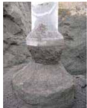
写真1. 土槽実験の混合スラグ 充填杭の節部直下
