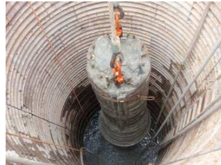
写真5 試験杭掘出し状況
