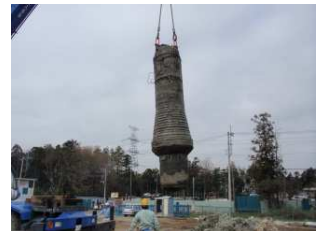
写真5 試験杭掘出し状況
