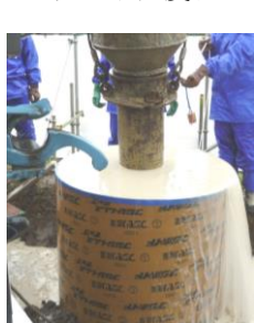
写真 - 1 コンクリート打込み状況
