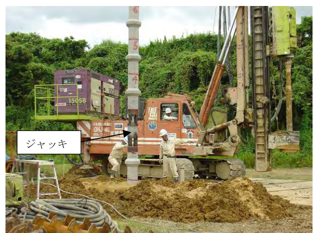
写真 1 No.2の施工状況
