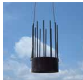
拡頭リングの吊り込み
