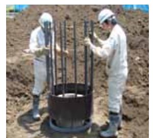
杭頭部への設置
