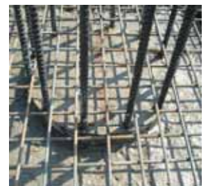
充填コンクリート・基礎配筋
