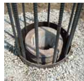
埋め戻し後の設置状況
