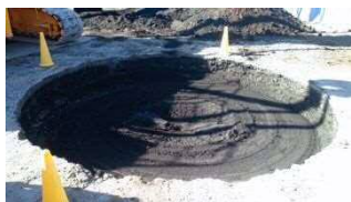
中間拡径部掘削完了
