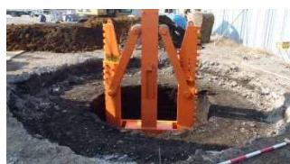
中間拡径部下部掘削
