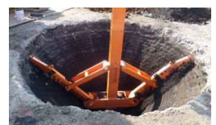
中間拡径部下部掘削完了
