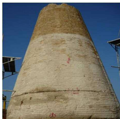
写真-2 掘り出したnew ACE杭
