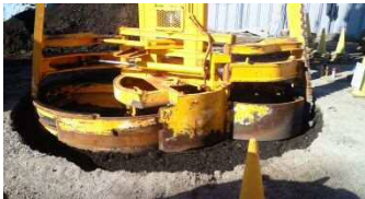
中間拡径部掘削
