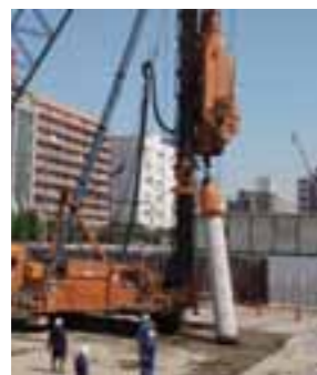
杭吊り装置(下杭)
