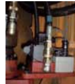
■油流量計 油流量を計測します。
