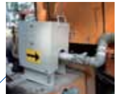
■流量計 水やセメントミルクの流量を計測します。
