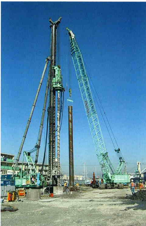
後沈設施工法全景
