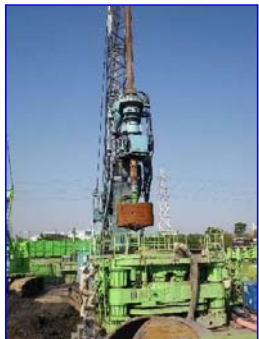
アースドリル工法
