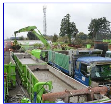
JSHR拡底掘削機状況
