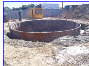
ライナープレート設置・掘削
