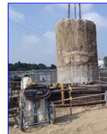
1断面目 引上げ
