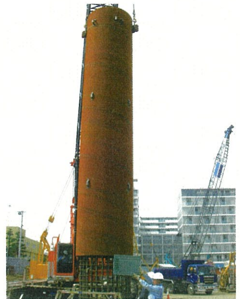
写真-1 KCTB 杭施工状況
