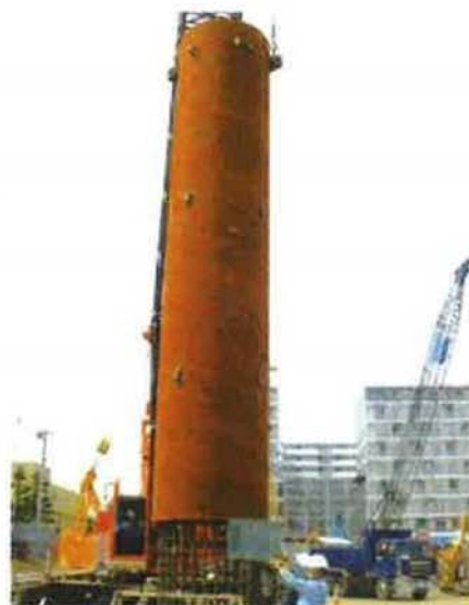
写真-1 KCTB 杭施工状況
