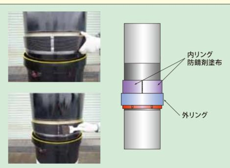
3 上杭と下杭の端板突起部に内リングをかみ合わせ、内リング外周面に防錆剤を塗布する。
