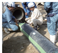
杭中空部に設置する様子
