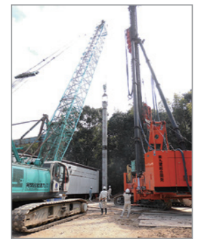
杭埋設の様子
