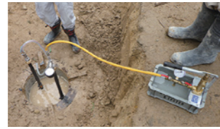
水圧試験の様子
