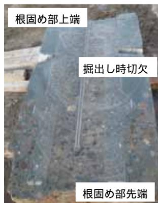
写真-4 軸方向の断面
