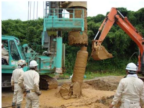
写真1 掘出し作業状況 (No.1)
