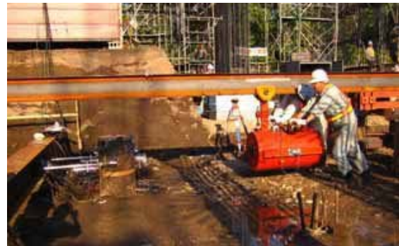
写真-1 人力方式による水平載荷システム
