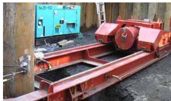
写真-2 電動方式による水平載荷システム
