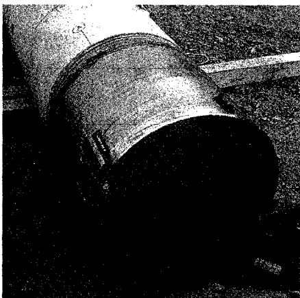
写真-5 既製杭に取り付けた先端ジャッキ
