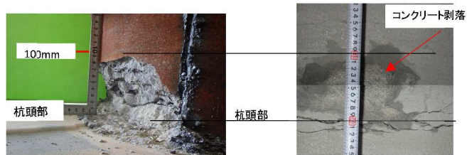
(a) 外殻鋼管除去後 (No. 1) (b) 杭内側 (No. 1)
