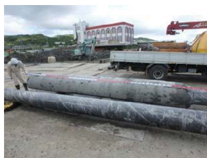
写真-2 掘出した試験杭 (手前: 上杭、奥: 下杭)
