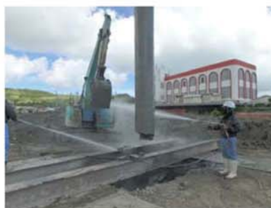
写真-1 掘出し状況
