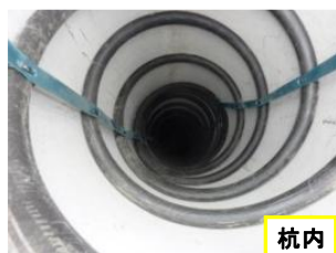
写真1 二重らせん状(スパイラル)チューブの杭内設置状況
