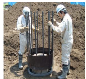
(2) 杭頭部への設置
