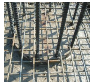
(4) 充填コンクリート・基礎配筋
