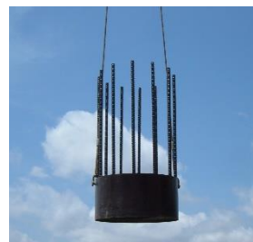
(1) 拡頭リングの吊り込み
