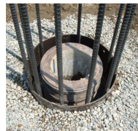
(3) 埋め戻し後の設置状況
