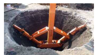
中間拡径部下部掘削完了
