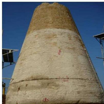
写真-2 掘り出したnew ACE杭
