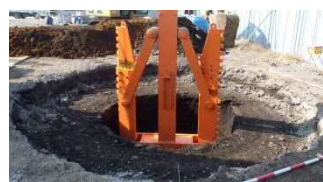
中間拡径部下部掘削
