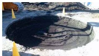
中間拡径部掘削完了
