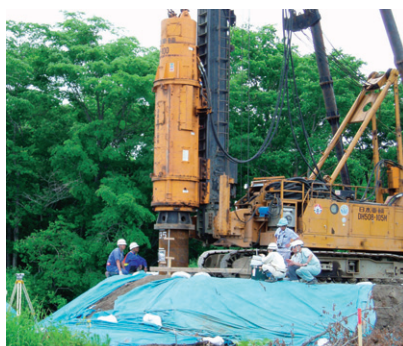
最大級油圧ハンマー使用例 (NH-100)
