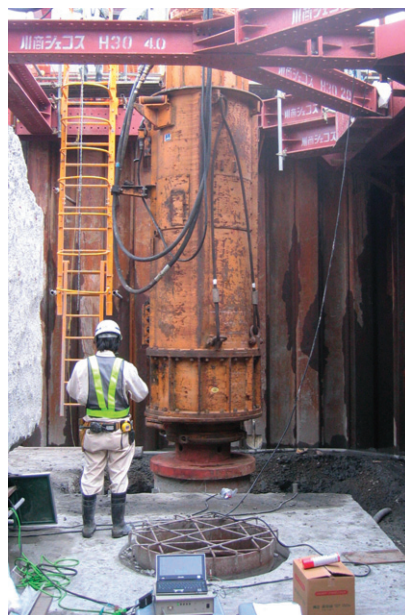
掘削孔内での試験例 (NH-70)
